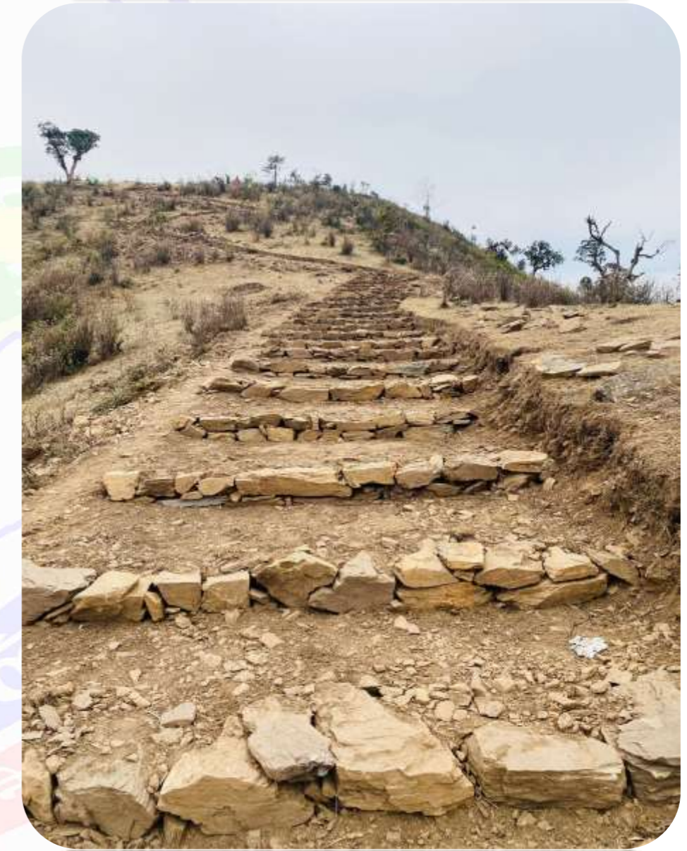
वडा नं. ६ सिंढी निर्माण
