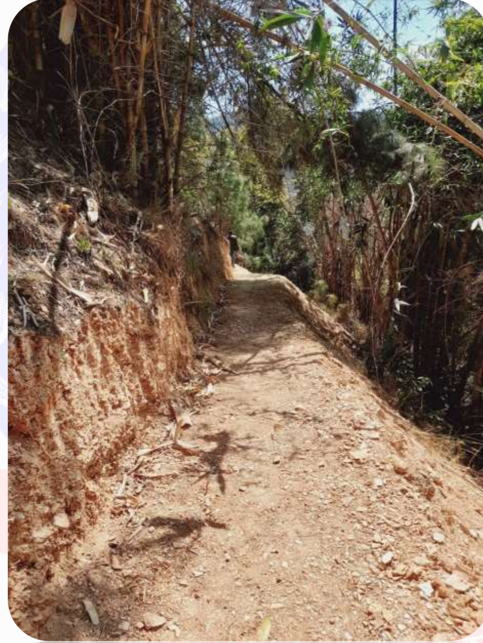
वडा नं. २ गो बा निर्माण
