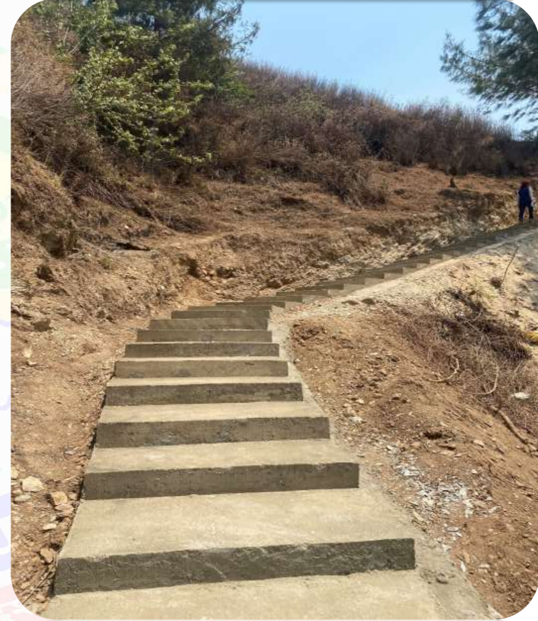
वडा नं. ३ सिंडी निर्माण
