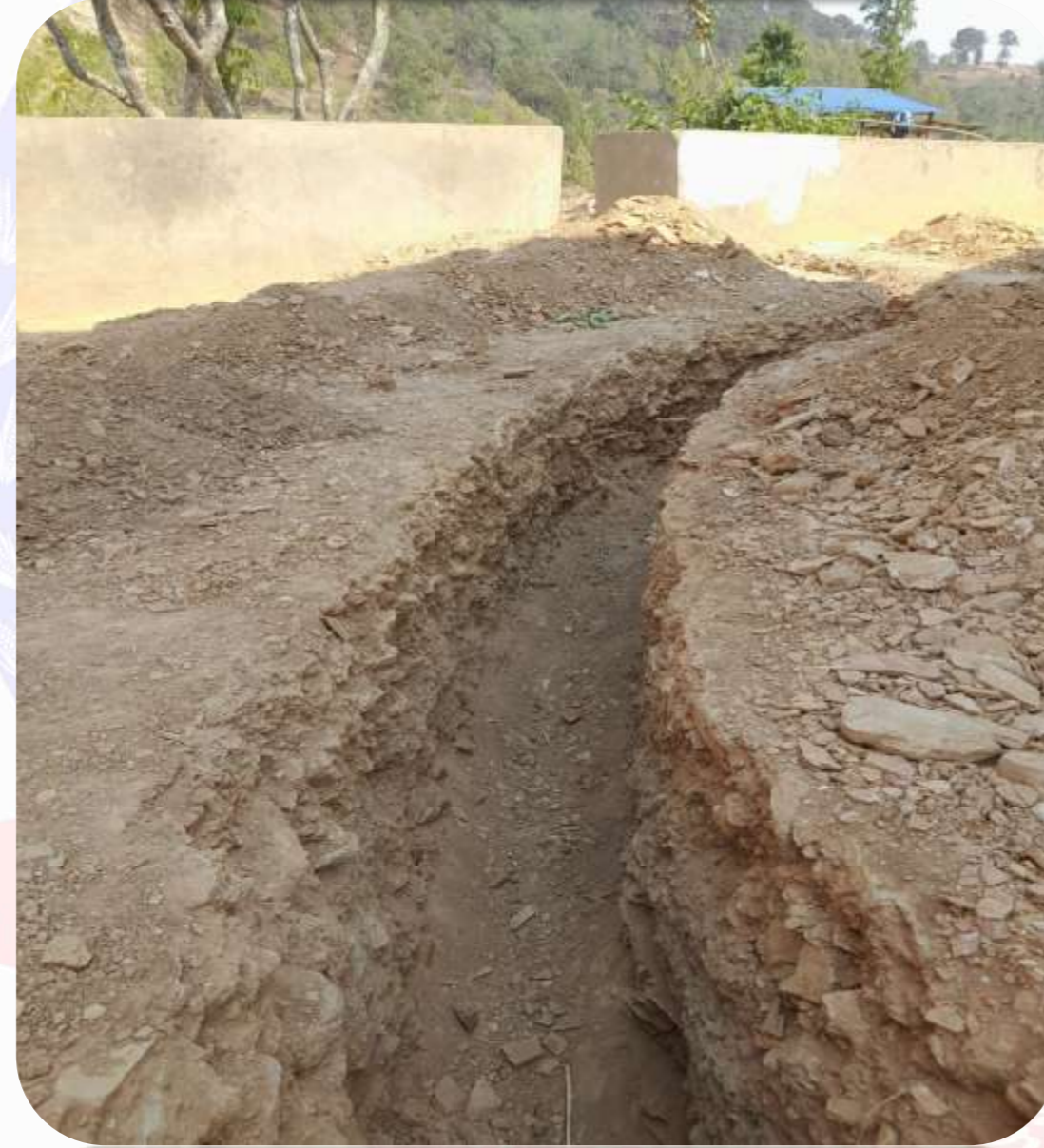
वडा नं. ५ पाईपलाइन निर्माण
