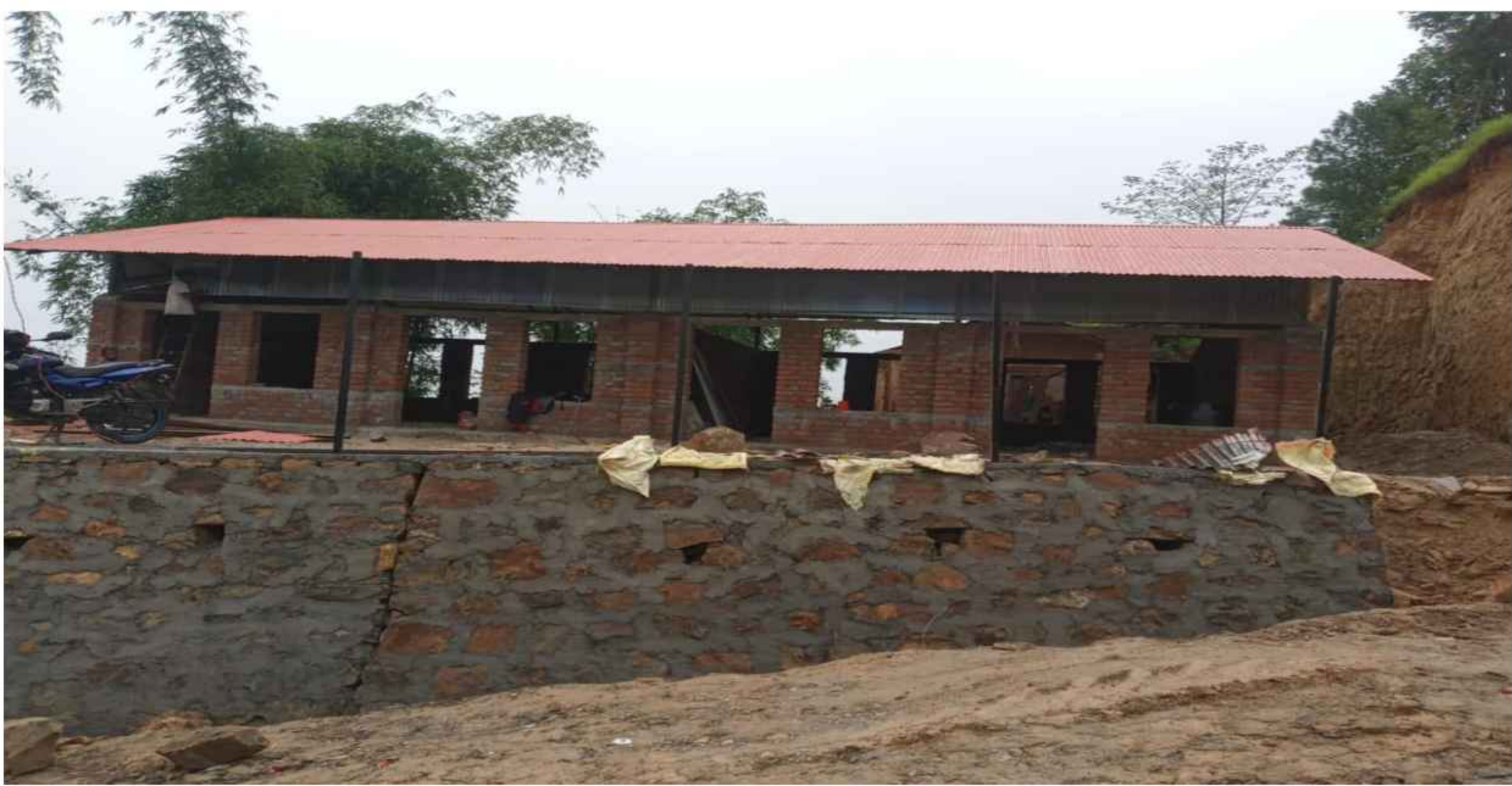
सिध्द नेरा मा.वि. भवन निर्माण
