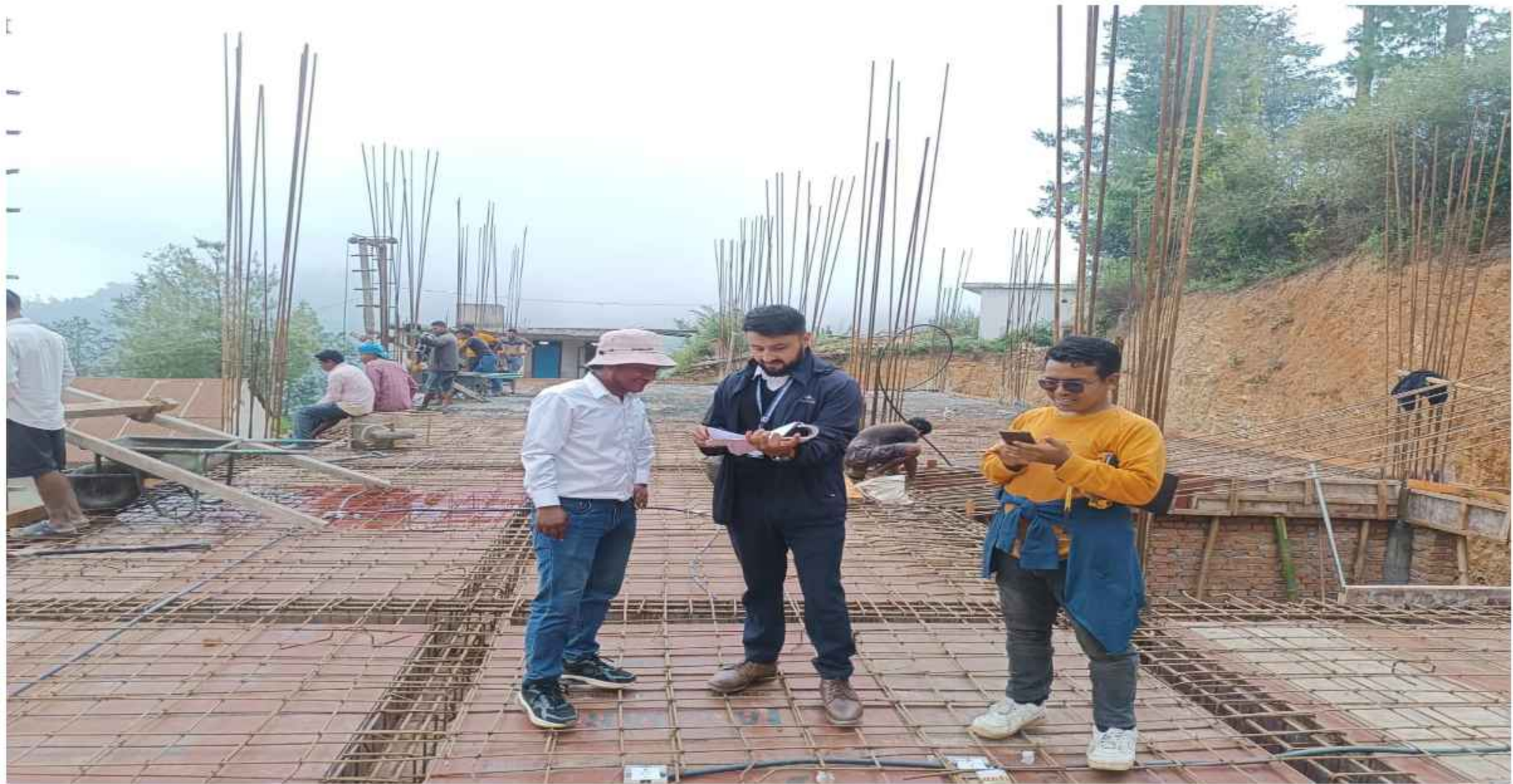
कालिका नेरा मावि भवन निर्माण
