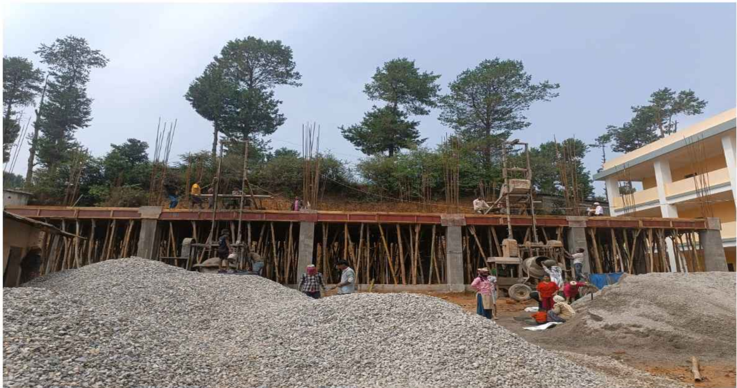
कालिका नेरा मावि भवन निर्माण
