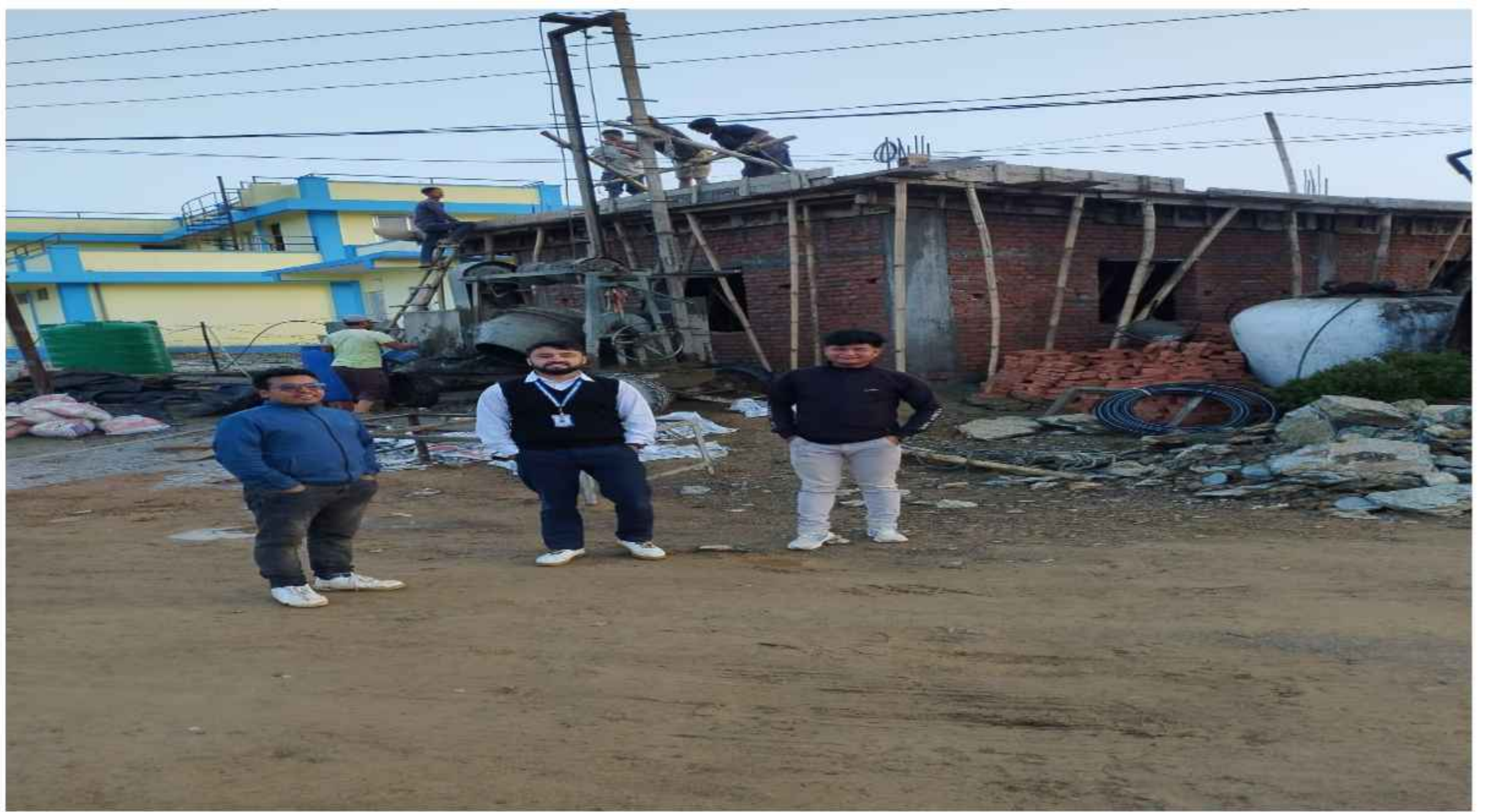
गोखूङ्गा स्वास्थ्य चौकी भवन निर्माण
