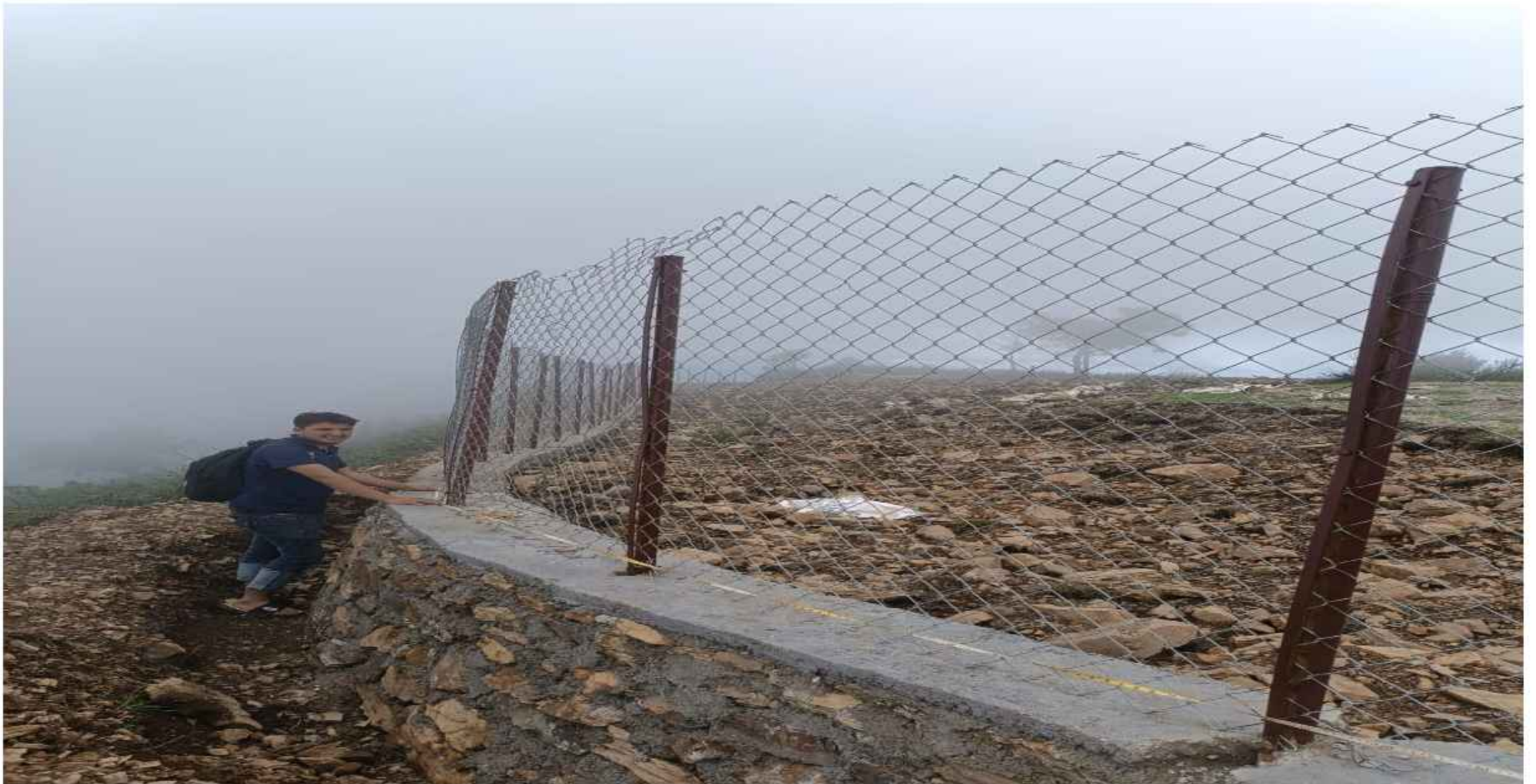
गडिको लेकमा पार्क निर्माण
